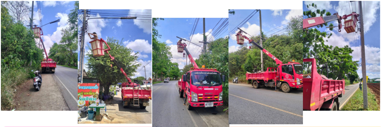
เดือนมิถุนายน 2568 กองช่าง อบต.ปากช่อง ดำเนินการซ่อมแซมไฟฟ้าแสงสว่าง ภายในตำบลปากช่อง จำนวนทั้งหมด 15 หมู่บ้าน
