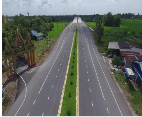
เสาไฟฟ้า
