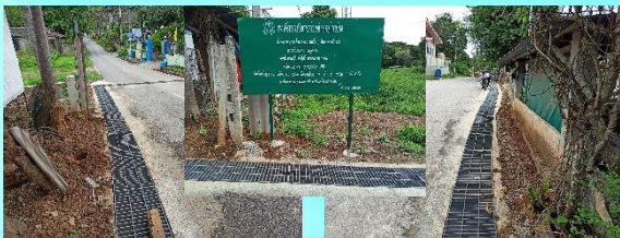
โครงการก่อสร้างรางระบายน้ำ (เส้นกลางบ้าน) หมู่ที่ 16 บ้านซับหวาย
