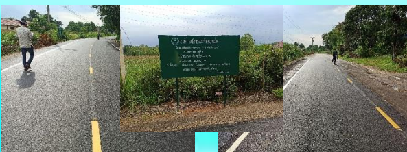
โครงการซ่อมสร้างถนนลาดยาง (เส้นกลางบ้านเชื่อมหมู่14) หมู่1 บ้านคลองตาลอง
