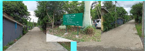
โครงการก่อสร้างถนน ค.ส.ล. (ซอยบ้านนางสมใจ) หมู่ที่ 3 บ้านโป่งประทุน
