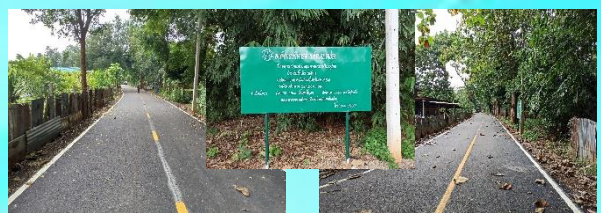
โครงการซ่อมสร้างถนนลาดยางภายในหมู่บ้าน หมู่ที่ 14 บ้านซับน้ำเย็น
